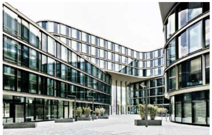
Bürohaus „LTD 1“ in Hamburg von Pysall Ruge Architekten (Berlin)
